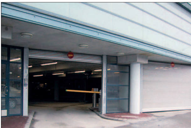
Garage entréer. Dörrarna är planerade att hålla tom. 600 öppningar per år. Genomsynlighet ger trygghet. Modell 2540, Ruohoparkki, Helsingfors.
