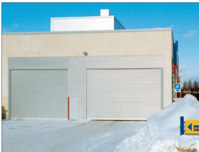
Rullportar av profil 2500, färg naturanodiserad. Här har vi även använt samma profil som inklädnad av vägg i mitten och ovanför, bottenprofilen är utrustad med klämlist. K-Supermarket, Ylöjärvi.
